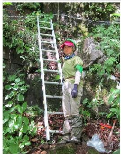
三階滝脇梯子、交換後
