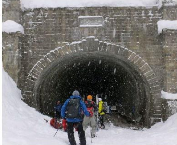
二ツ小屋隧道入口
