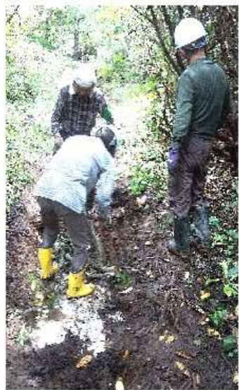
水溜まりに、土嚢袋
