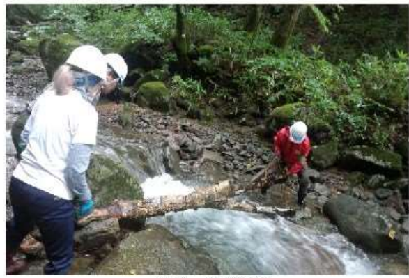
仮橋、架橋作業
