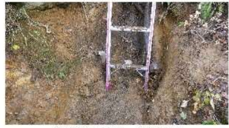
梯子の足下は、杭で固定
