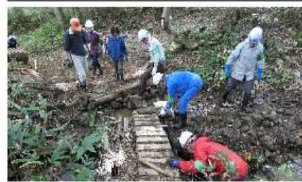
金剛清水橋での溢水防止工事
