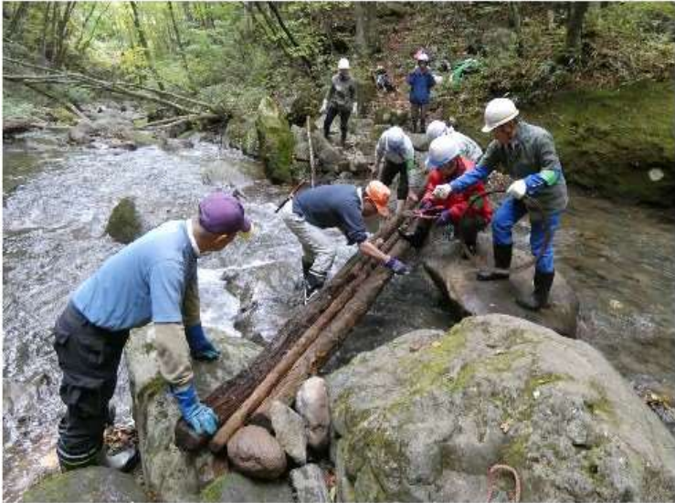
流出した橋材戻して架橋作業
