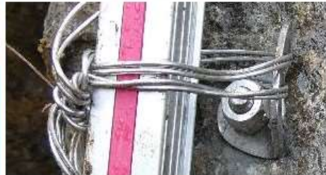
下のボルト止め
