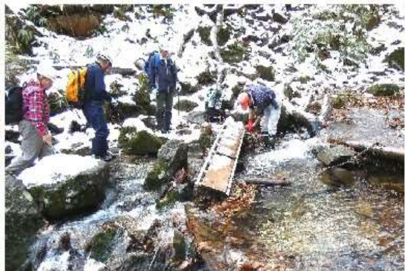
荒竜岩下橋、撤去作業
