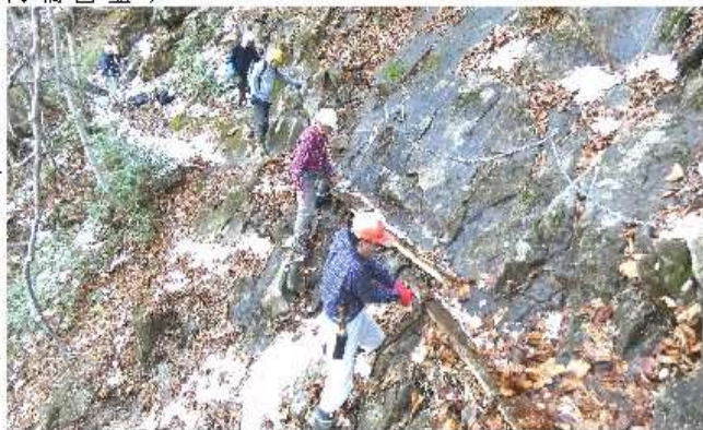
屏風岩向、栈橋撤去
