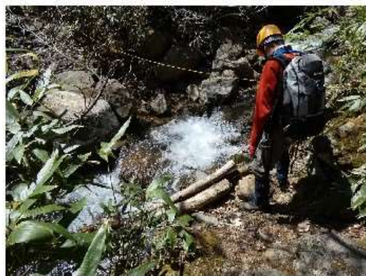
落橋している、⑦天狗庭橋
