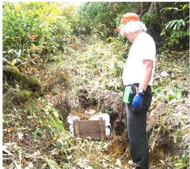
完成した階段
