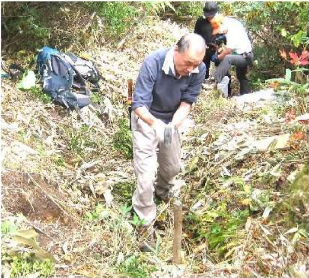
工事中(溶岩堤防添い)
