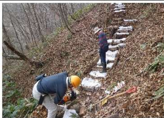
13時54分、階段工事中
