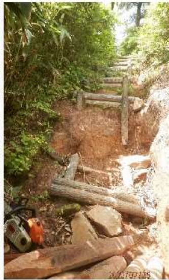
1ヶ所目、作業前
