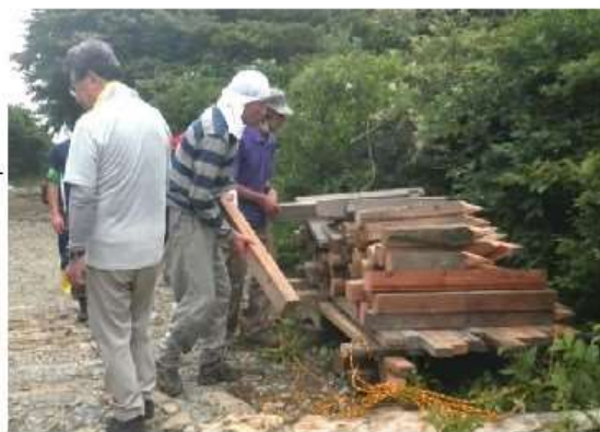
ブルーシート外すと、材料が現れました
