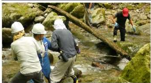
一時間ほどの作業で、掛け直し作業は終了した。
