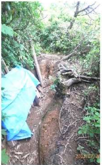
2ヶ所目、作業前
