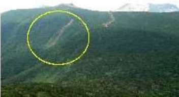
石垣岩下の崩落、箕輪山頂から
