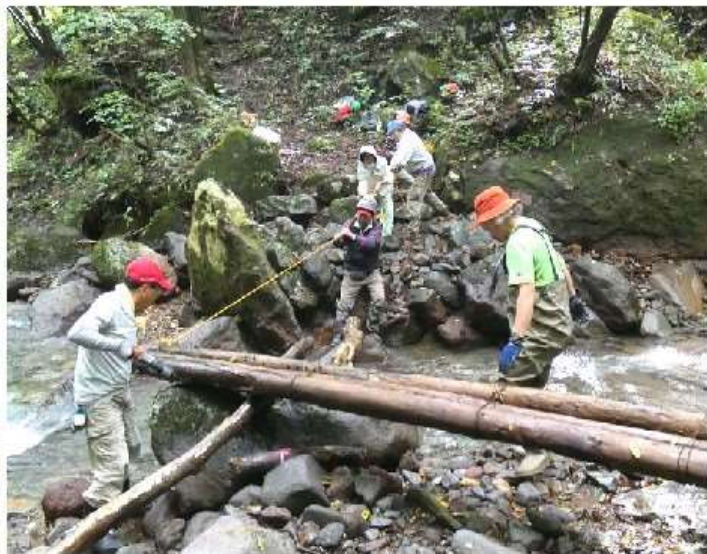
仮橋の上滑らせて、架橋した
