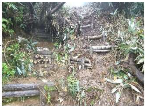
左の階段は元の道、土砂被ったので、右に臨時の仮階段設置
