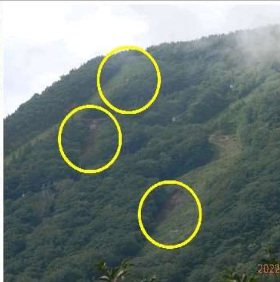
スキー場上部の崩落場所
