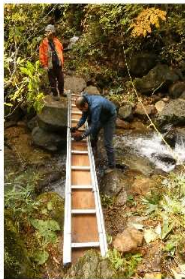
橋板固定作業
