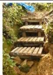
完成した階段
