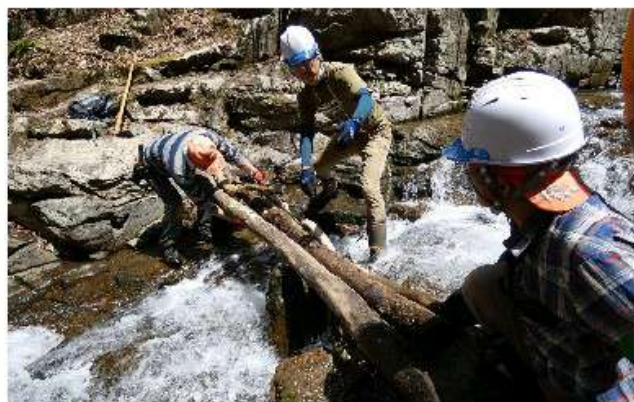
④荒竜岩「下」橋、架橋作業
