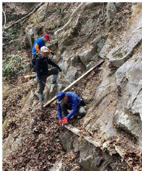
屏風岩向の棧橋工事
