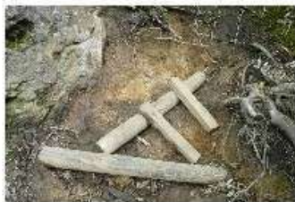
スキー場上、末端崖の壊れた階段
