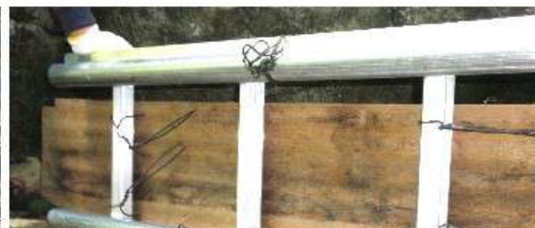
パイプとハシゴ、橋板の固定
