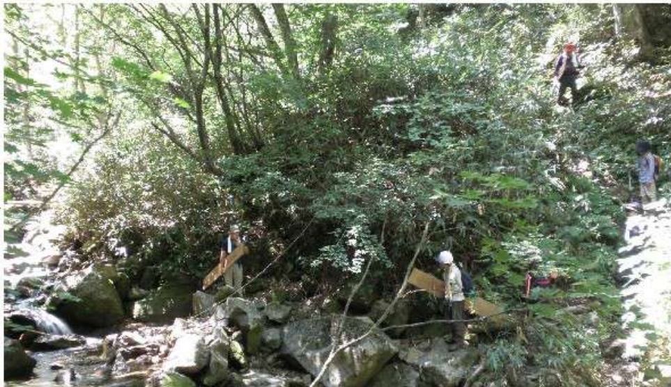
11時8分 橋板3枚共、架橋現場到着
