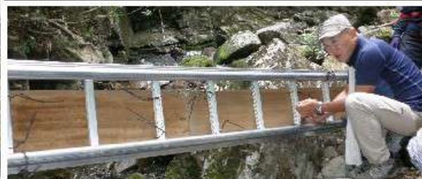
完成した橋の裏側
