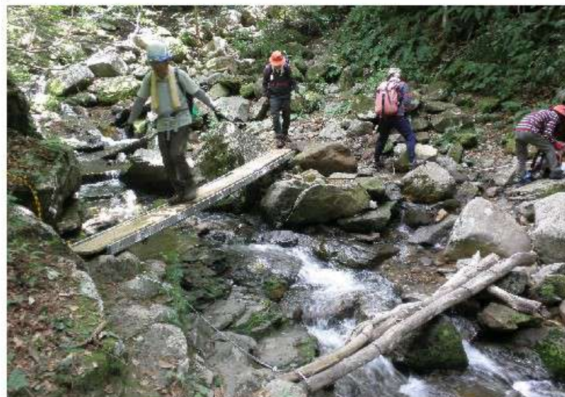
13時14分、新しい橋完成、前の橋もそのまま
