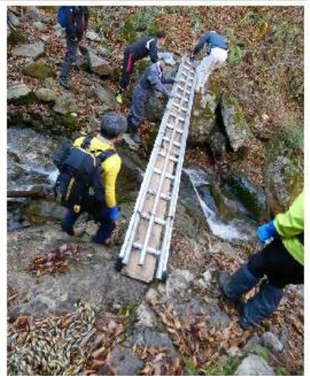
橋の裏側に、補強用の鉄パイプ付いている、重いので外す。
