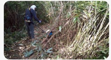
お昼近くになり、休憩所を過ぎ会長、 さん、 さんと合流。大きく崩れた道の補修(バイパス作り)をしていた3人の手伝いに入る。笹や木の根を切断する作業、大きく掘ってしまった道に笹の束を寝かせ暗渠にする作業などを行う。
